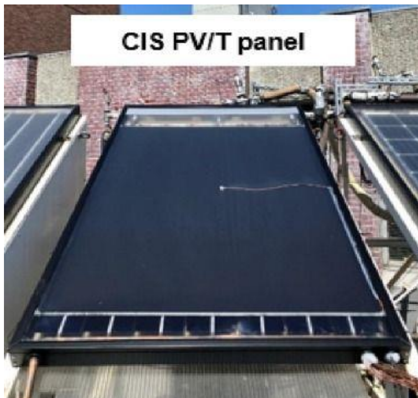
شکل ۱. عکس یک پنل خورشیدی کاربردی CIS PV/T.
