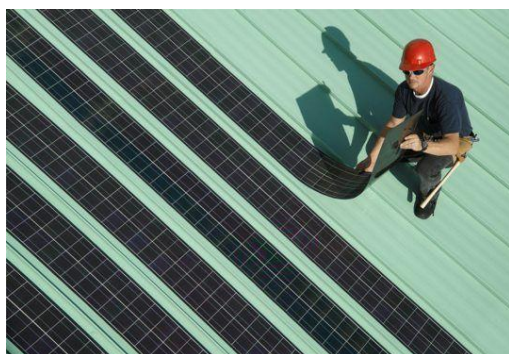
شکل ۲۳- تصویری از ورقه‌های فتوولتائیک (پیتترست نیو رولبل سولار پنلر میک روف اینستالیشن | اسنپ)
