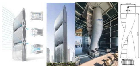
شکل ۱۲- توربین و نحوه عملکرد آن در برج رودخانه پرل (پیتترست برج رودخانه پرل).
