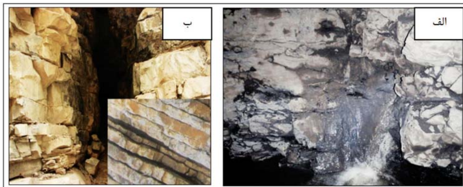
شکل ۱۶. الف) خروج جریان آب در امتداد بازشدگی‌های دیواره سمت راست تونل در محل تاقدیس کردی قاسمان (مهندسین مشاور ایمن‌سازان، ۱۳۸۵)، ب) واحدهای کربناتی در تاقدیس کردی قاسمان (دید به سمت غرب)
