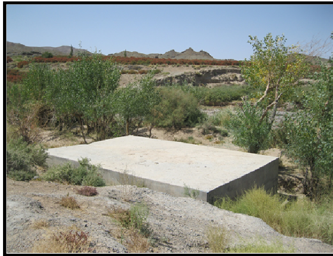
شکل ۲: نمای کلی خانه تقسیم آب
