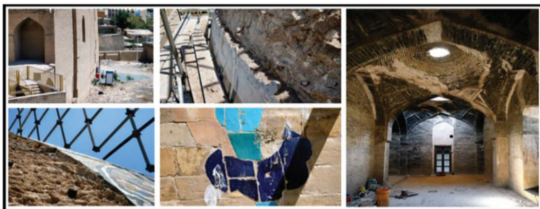
تصویر شماره (۳): لایه‌های ساخت از جمله مصالح بنایی و کاشی مسجد شیخ لطف‌الله
