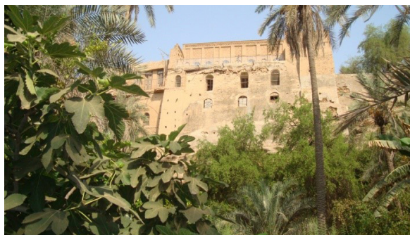
تصویر شماره ۷: ارتباط بصری با باغ خان از منازل مسکونی اطراف
